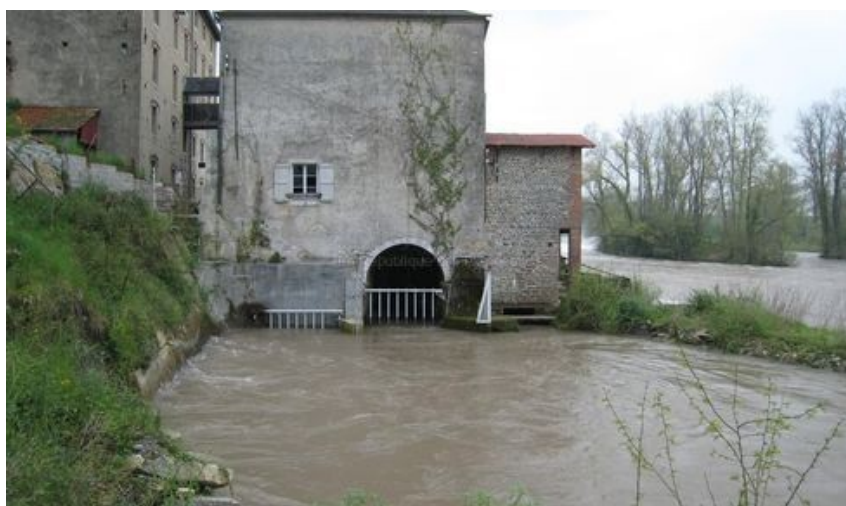
La centrale du Maseys, près de Navarrenx, exemple de microcentrale fleurissant sur les gaves du département. © archives pp
